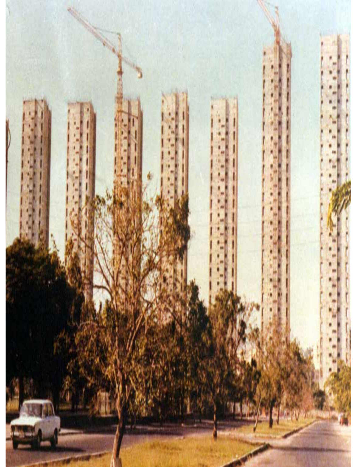
عمارات الميراند طريقة البلاطات المرفوعة
