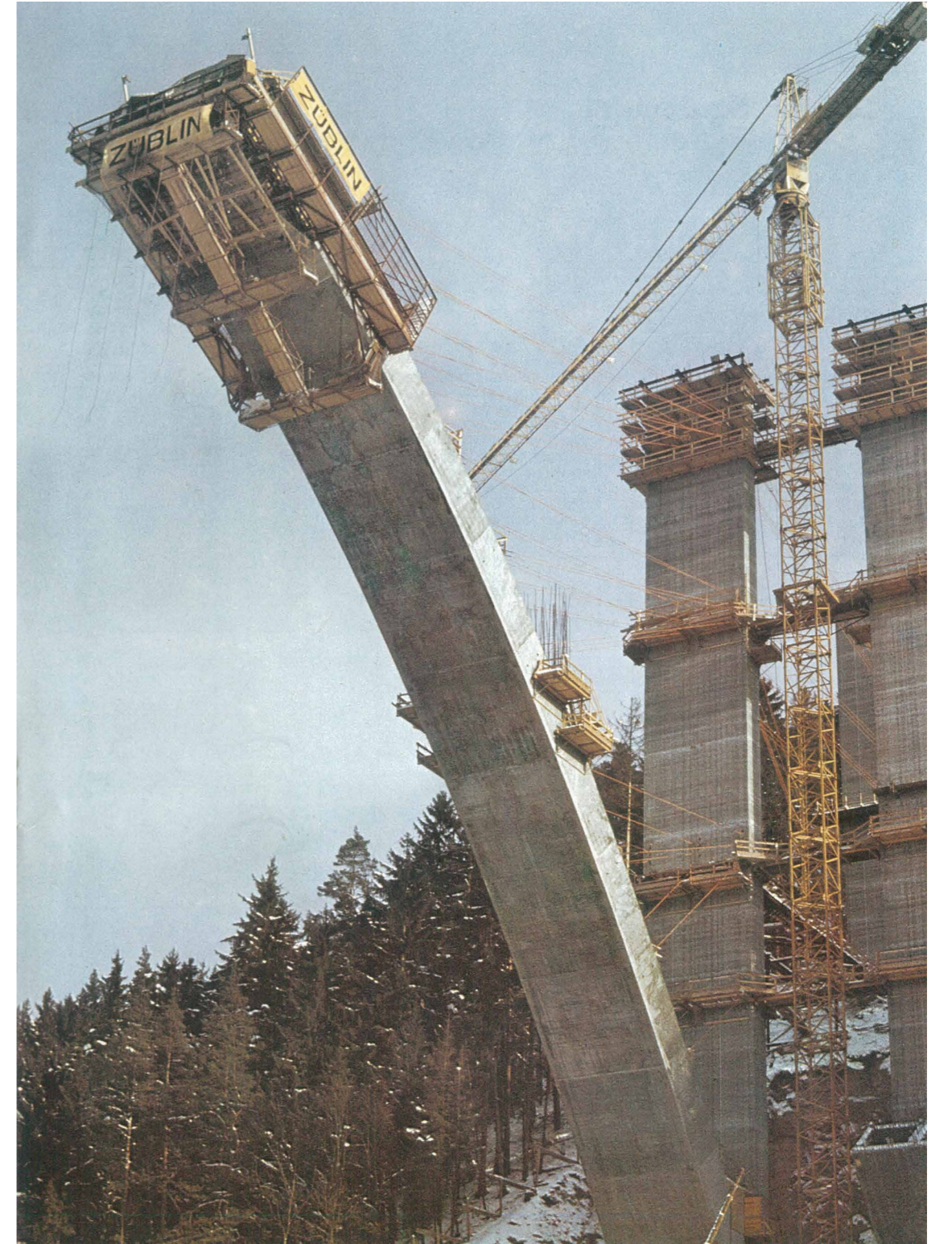
أستخدام الشدات المنزقة في أنشاء أحدى الكبارى
