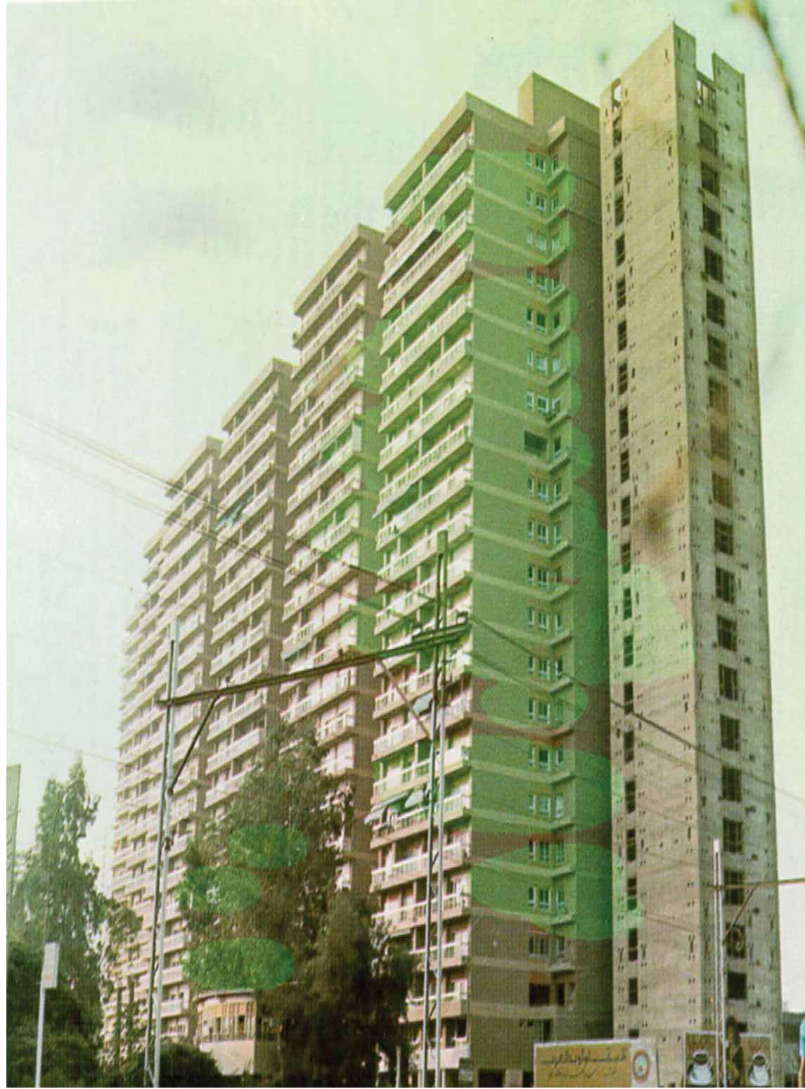
عمارات الميراند طريقة البلاطات المرفوعة
