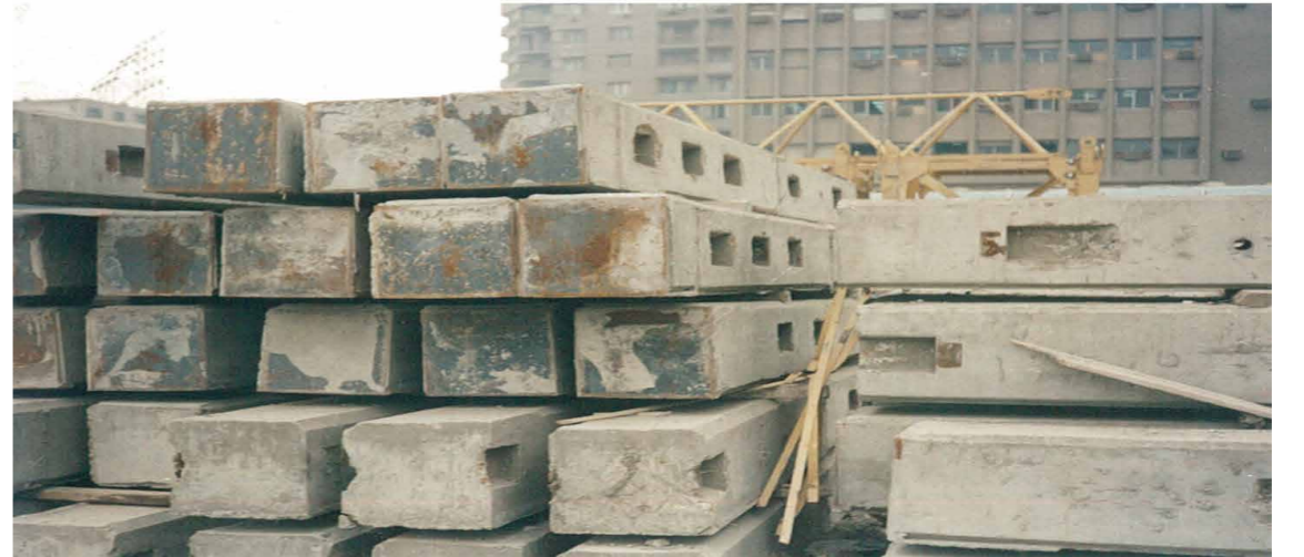
خطوات تنفيذ البلاطات المرفوعة مشروع شيراتون مطار القاهرة
