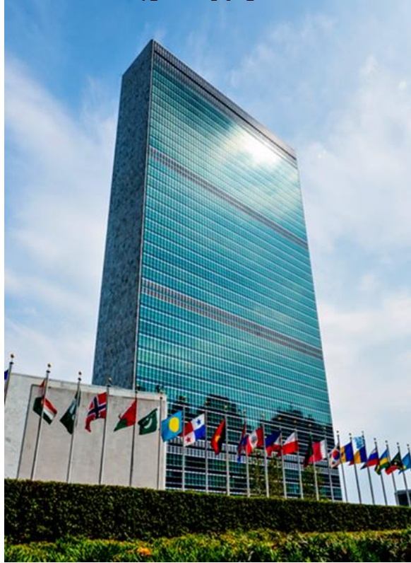
واجهة مبنى مستطيل حيث يتم التركيز على الواجهة الرئيسية _مبنى الأمم المتحدة
