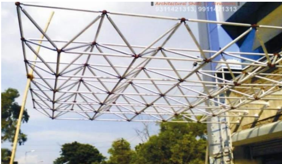
Space truss الاسقف الفراغية
