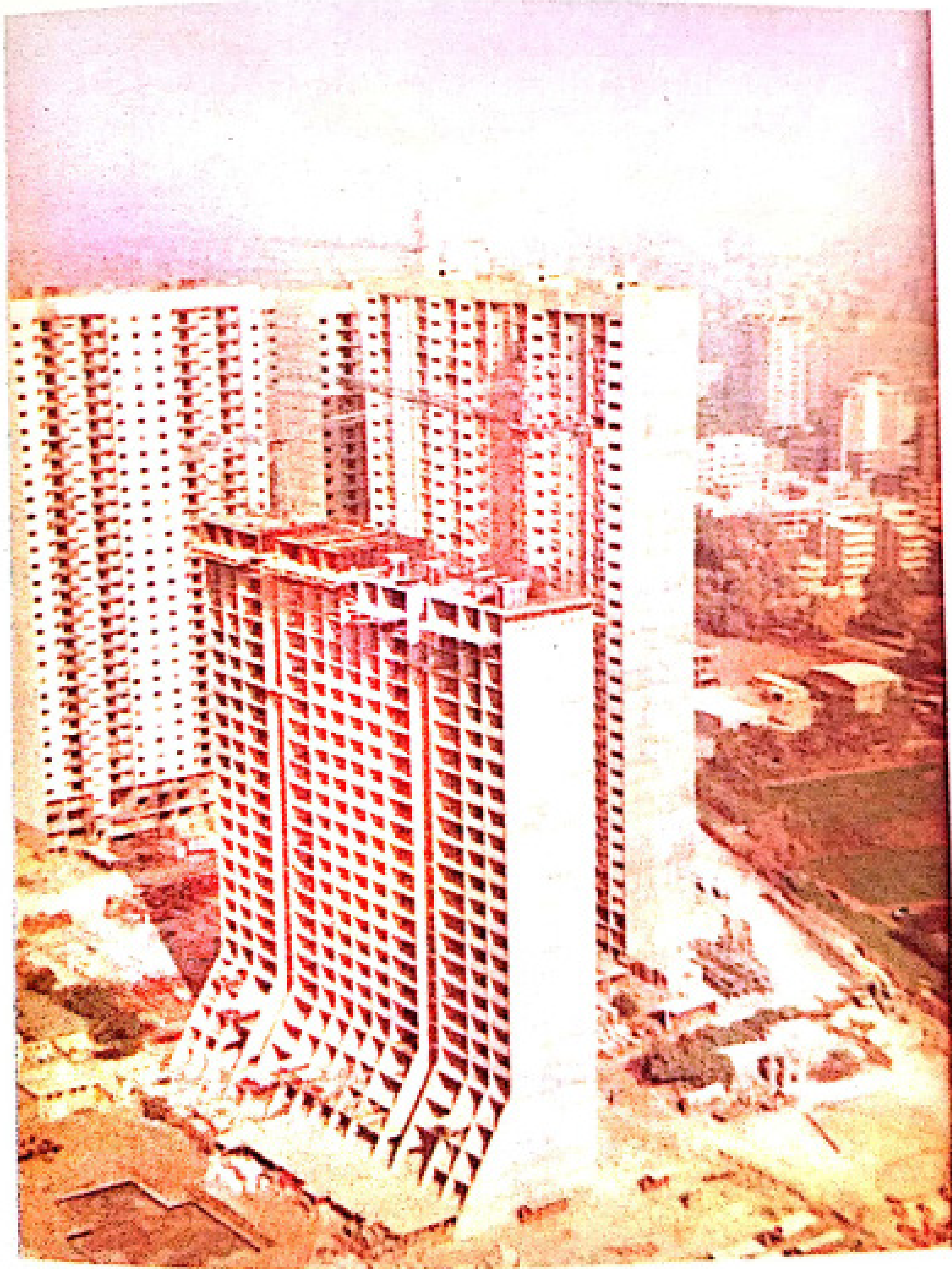
صورة أحد المباني القائمة في ضواحي القاهرة والمستخدم في إقامتها نظام الشدات المنزلقة
