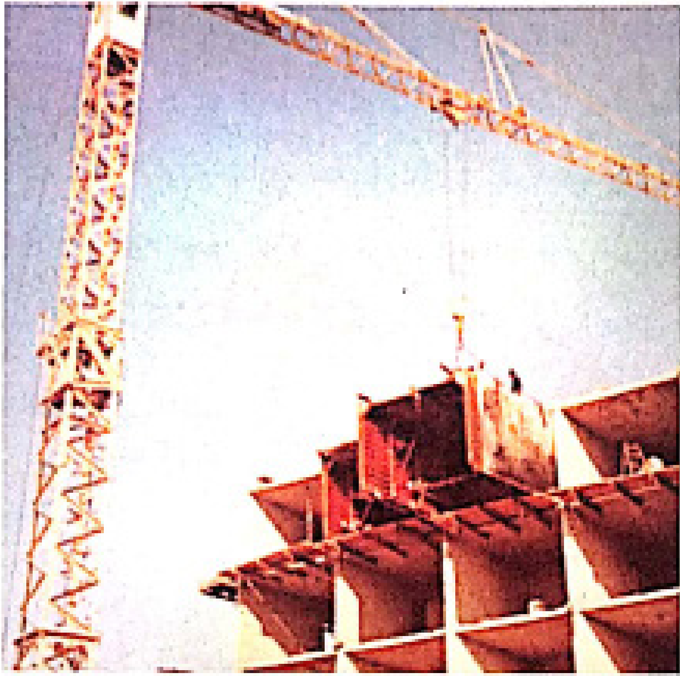
الصورة توضح شكل الشدات المنزلقة وطريقة وضعها لصب الحوائط والأسقف لإقامة المباني في أحد مناطق القاهرة
