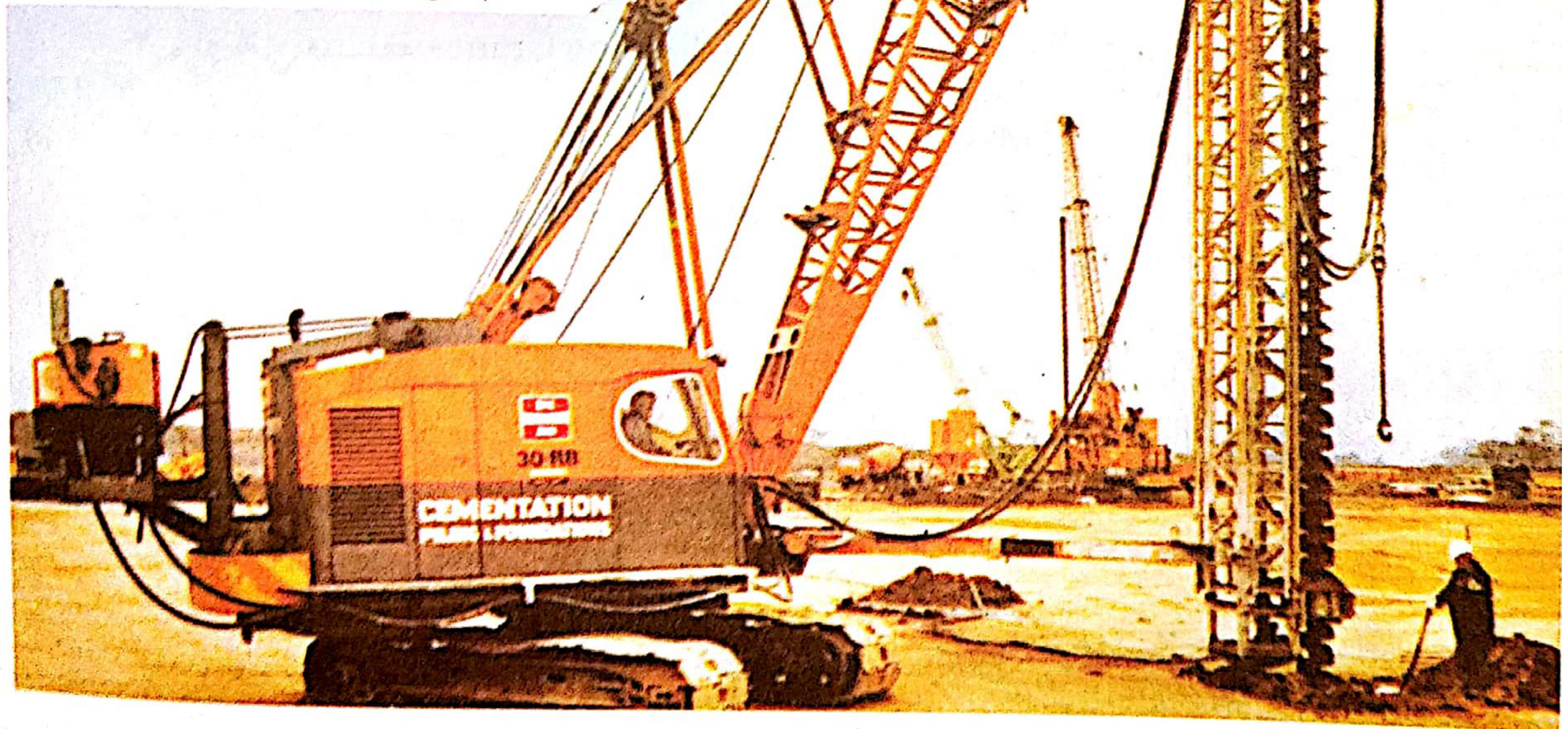
الصورة توضح احدى آلات خوازيق الثقب ( البريمة ) Pill Drill
