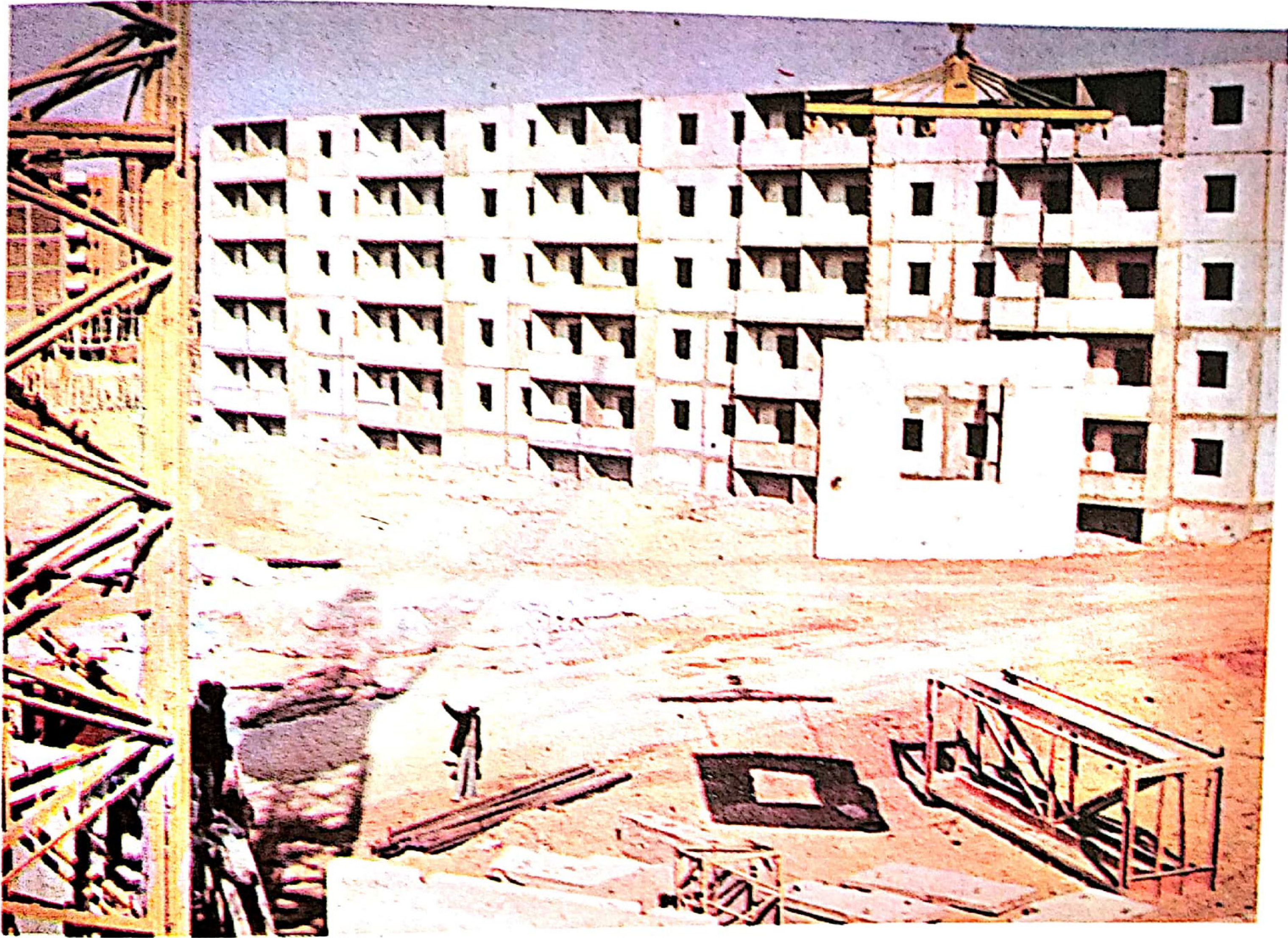
إستعمال الوحدات المستوية الكبيرة الحجم في بعض المشاريع بالقاهرة
