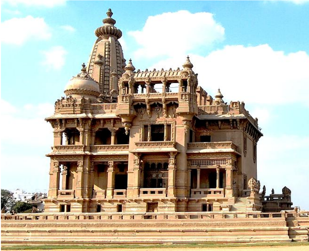
قصر البارون امبان قبل الترميم
