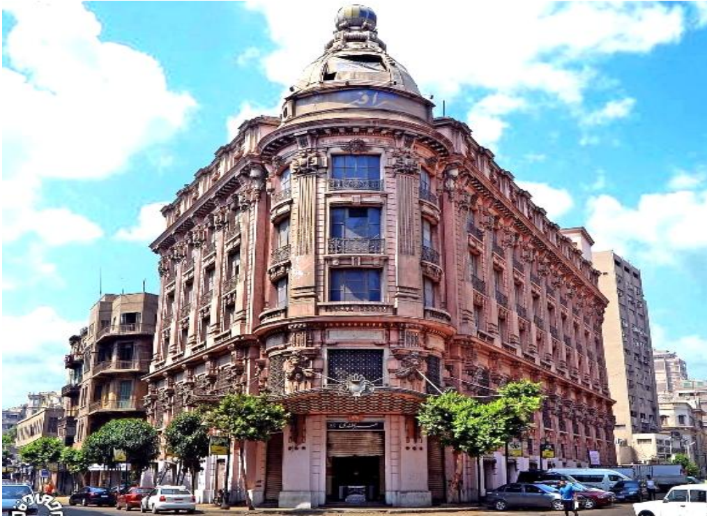
مبنى عمر أفندي
